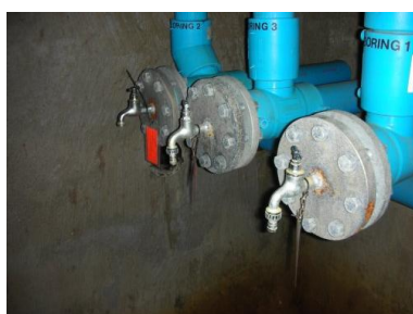
Prøvehaner råvand indgang vandværk
