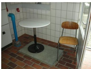
Nedgang til rentvandstank
